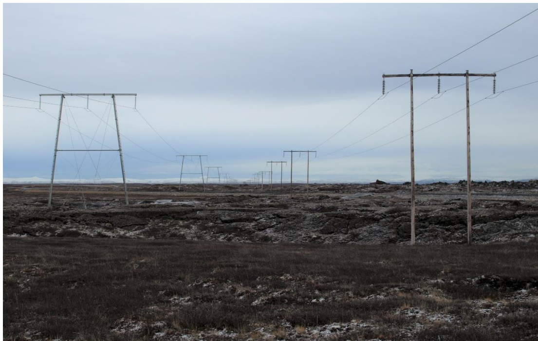
Mynd 6. Mismunandi haflengd og umfang nýrrar 220 kV línu og gömlu byggðalínunnar má sjá á þessari mynd sem tekin var á Mývatnsöræfum í lok október 2020 (ljósm. höfundur).
