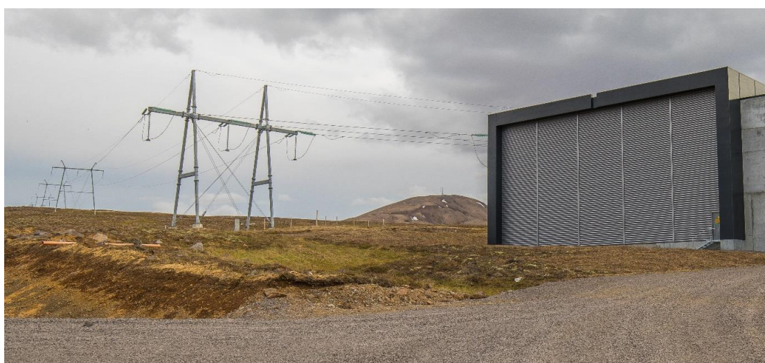
Mynd 3. Dæmi um endamastur hjá tengivirki við Bakka norðan Húsavíkur (Landsnet, 2020a).
